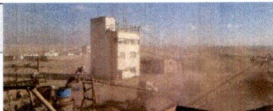
ساختمان کارگاهی موجود در معدن
