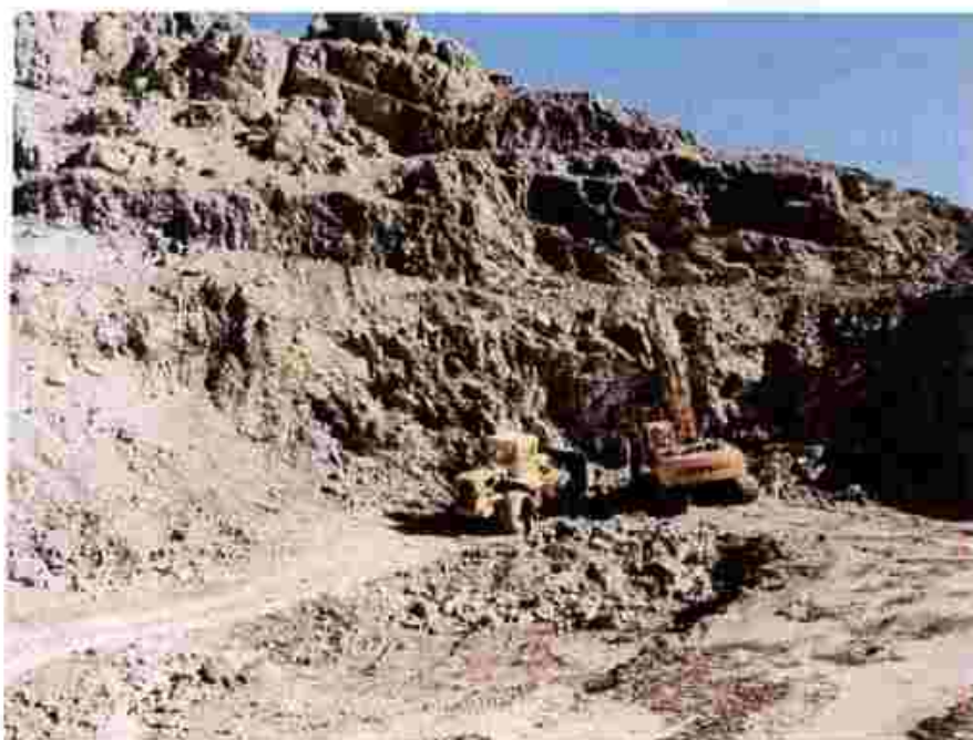
عملیات آماده سازی پیش کارهای اکتشافی و استخراجی در یکی از انومالی های معدن مس کنگن
